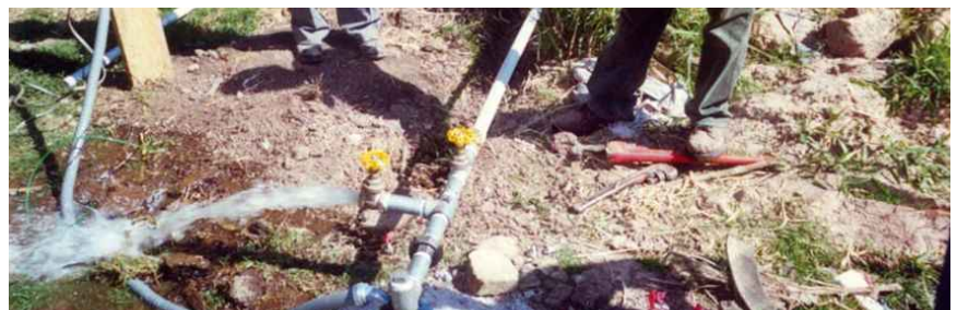
Puesta en marcha de bombeo del proyecto subvencionado
